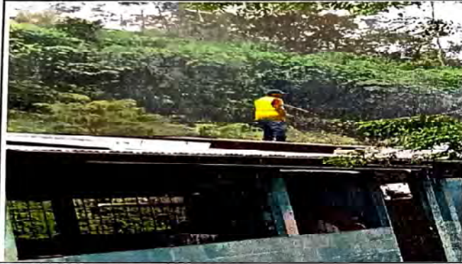
Foto 1: Inicio del desmontaje del techo.
