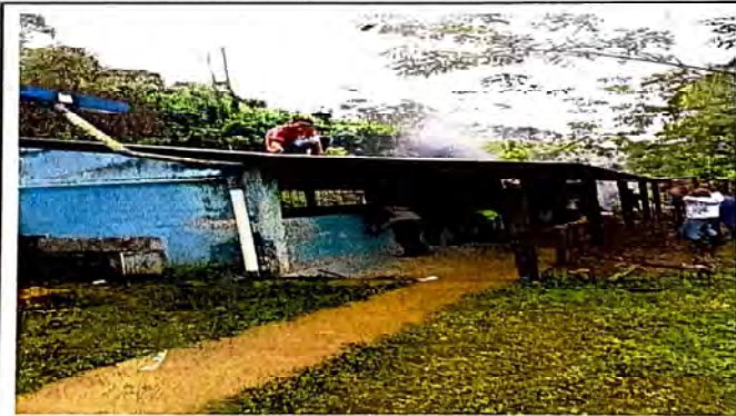
Foto 4: Inicio de reparación de repello y cernido de paredes.
