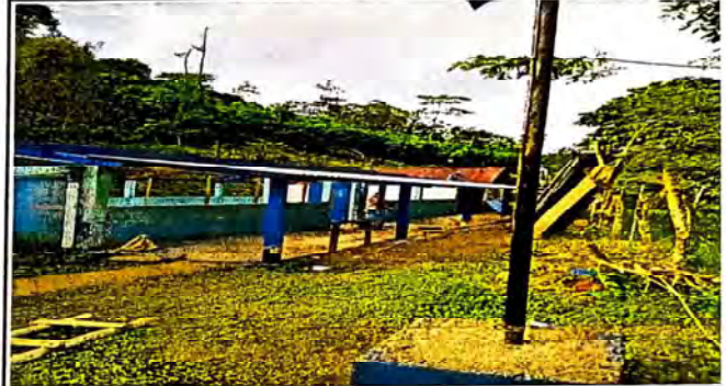
Foto 2: Desmontaje de techo de las aulas.
