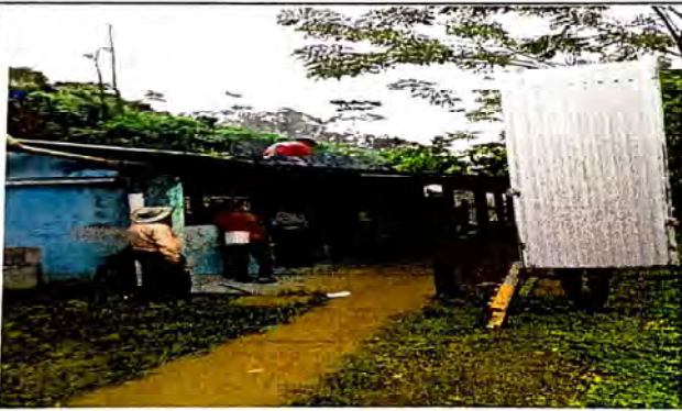
Foto 3: Inicio de la sustitución de laminas de las aulas.
